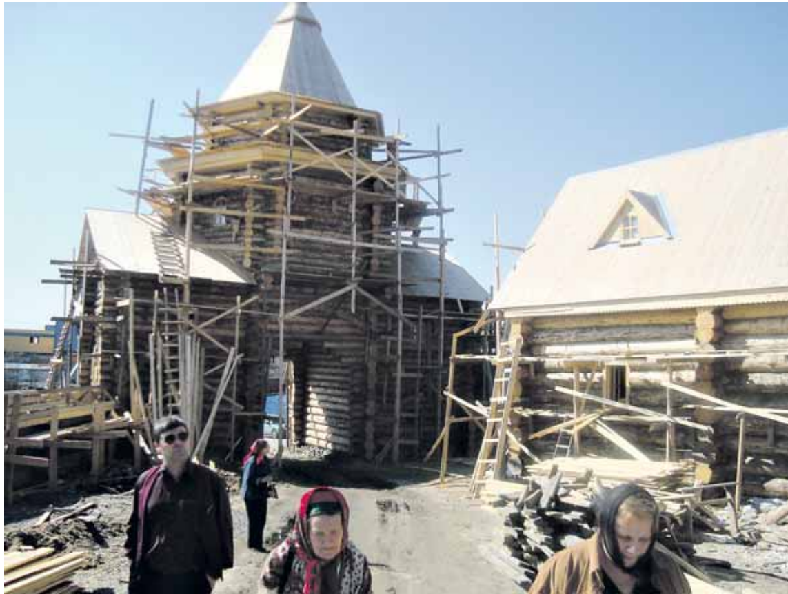
Petsamon luostarille rakennetaan Murmanskiin podvorია. Rakennustyömaa on valtava. Valokuva: Ritva Naakka.
