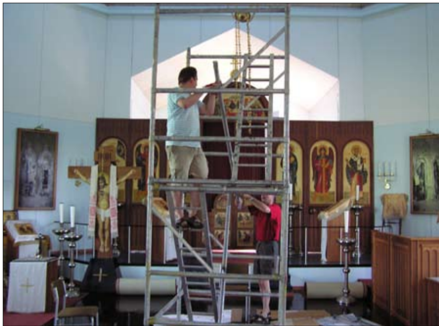
Talkoolaiset rakensivat tellingit kirkkosalin keskelle ja purkivat tornin eristyksen.
